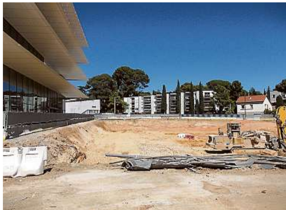
Le bétonnage plus avancé est aussi pointé du doigt.
